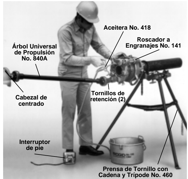
Figura 18 – Roscado de tubos usando un Árbol Universal de Propulsión No. 840A
